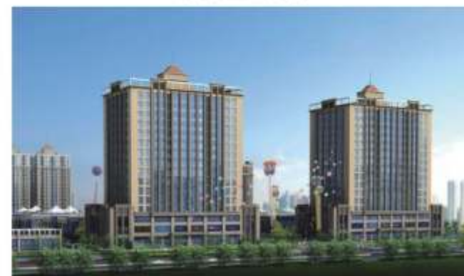
华东国际商品展贸中心（地下人防工程验收）
