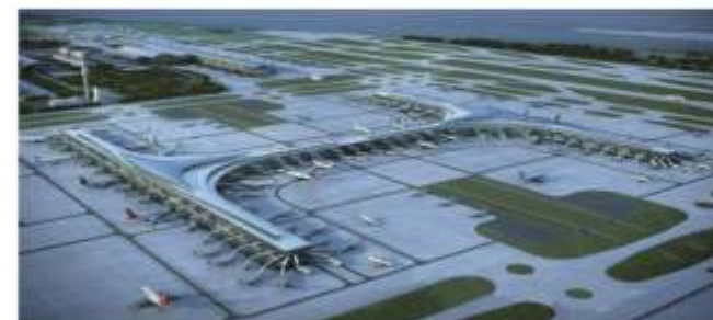
浦东机场三期扩建（飞行区助航灯光及站坪照明工程检测）
