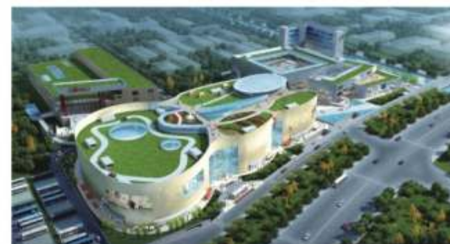
元祖梦世界（建筑节能现场检测）
