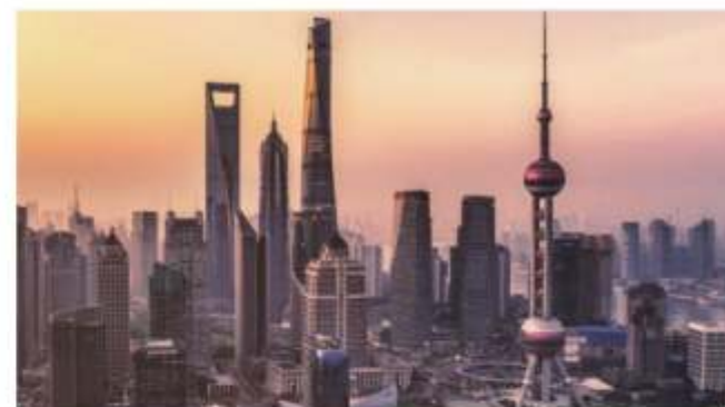
上海国际金融中心 （节能材料检测、节能构造钻芯检测）
