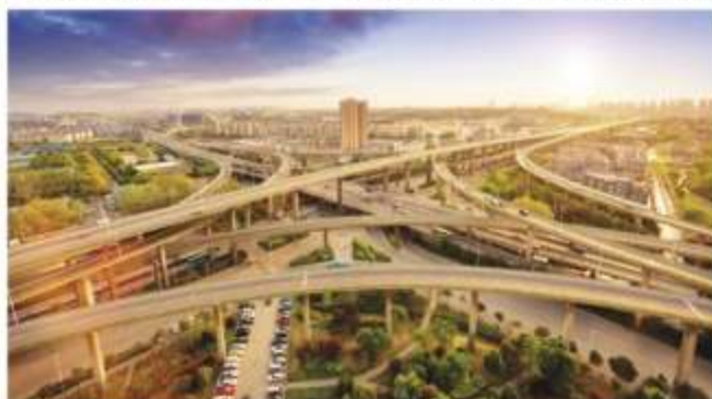
虹桥交通枢纽立交桥（钢结构、桩基、材料检测）
