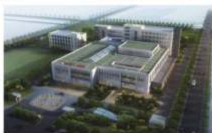
崇明县第三人民医院迁建工程项目 (放射防护评价)
