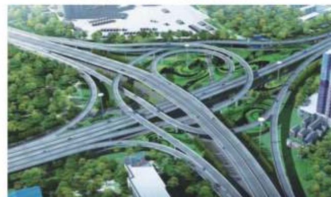
昆山中环快速化改造工程 （公路工程检测、混凝土浇筑质量监控管理）
